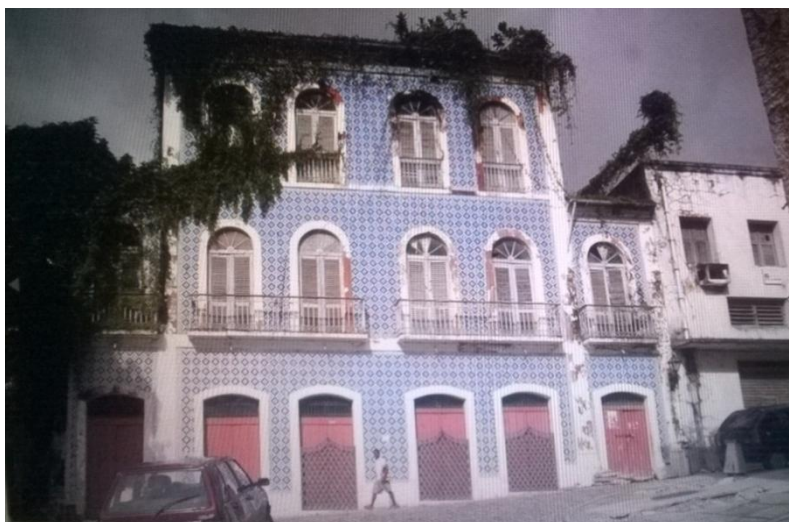
Fotografia 17 - Prédio Rua da Estrela. Antes da reforma. Fonte: IPHAN
