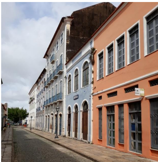
Fotografia 8- Casarões na Rua Portugal. Alinhamento. Fonte: Registro fotográfico do autor (2018).
